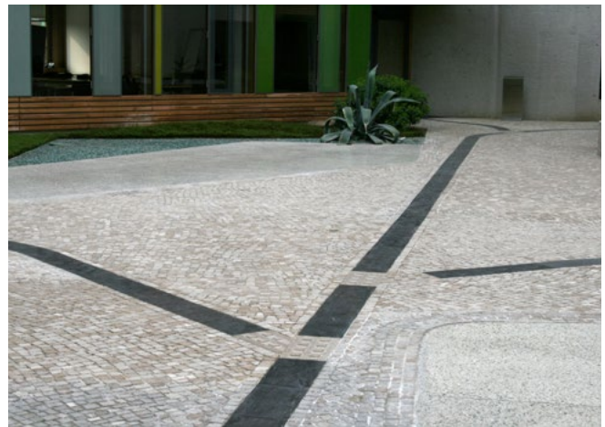
Abb. 2 Einsatz von Bodenindikatoren
