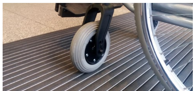
Abb. 4 Vermeidung von Schlitzen und Öffnungen im Bodenbelag
