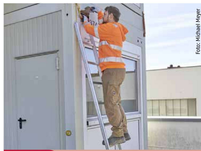
Flop Wackliges Arbeiten auf Sprossenleiter
