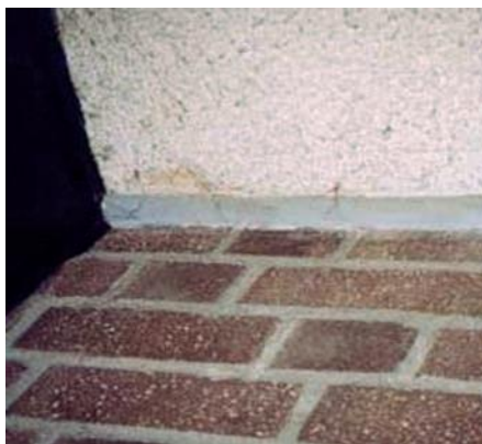
Abb. 4: PCB-haltige Fugenmasse
