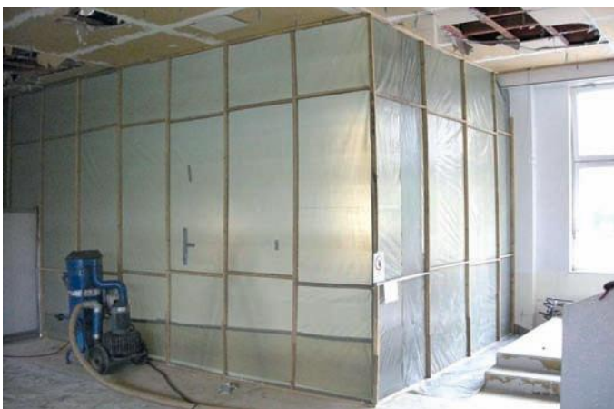
Abb. 10: Staubdichte Abschottung
