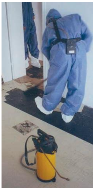
Abb. 1: Ausbau asbesthaltiger Fußboden- beläge (Flexplatten)
