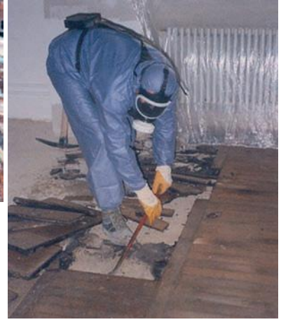
Abb. 7a, b: Sanierung PAK-haltiger Parkettkleber
