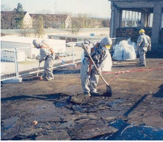
Abb. 6: Ausbau PAK-haltiger Dachbahnen
