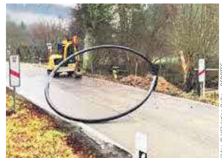
Ende des Rohrmaterials kurz nach dem Herausschlagen
