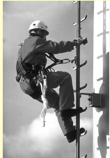
Abbildung 7: Verlängerung Abstand Körper zum Auffanggerät durch zu locker angelegten Gurt
