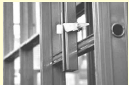
Abbildung 8: Ungeeignete Endsicherung des Steigschutzes an einer Leiter
