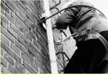
Abbildung 5: Ungeeignete Befestigung an der seitlichen Halteöse des Auffanggurt
