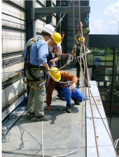
Abbildung 5: Horizontale seilunterstützte Arbeitsplatzpositionierung auf einem Dach (bewegliche Führung) (BGIA)
