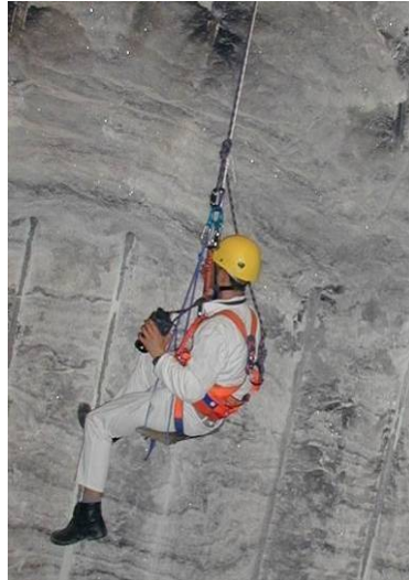
Abbildung 8: Person wird auf handbetriebenem Arbeitssitz abgeseilt – Sicherungsvariante C 2 (BGIA)
