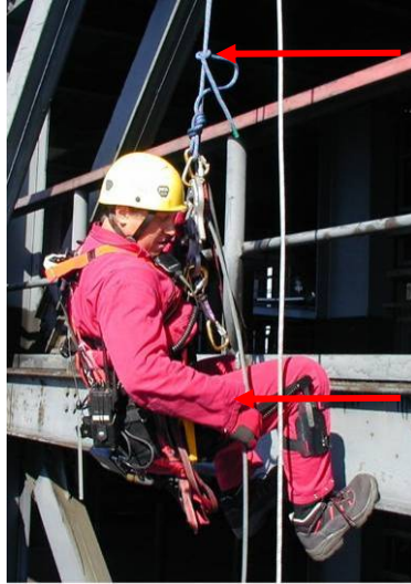
Abbildung 7: Seilunterstützter Zugang über eine bewegliche Führung, Sicherungsvariante B2 und B3 kombiniert (BGIA)
