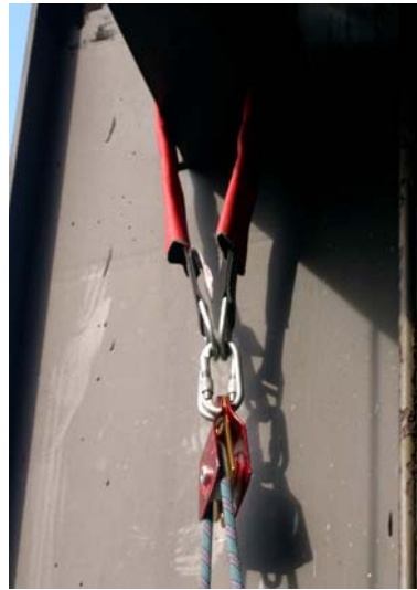
Abbildung 1: Installation einer Seilrolle als Umlenkpunkt für ein Seil
