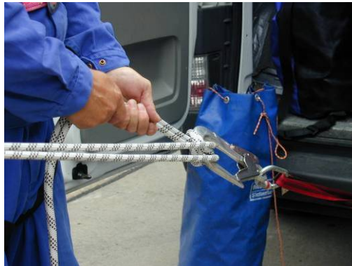
Abbildung 28: Installation Schrägseil im Gelände
