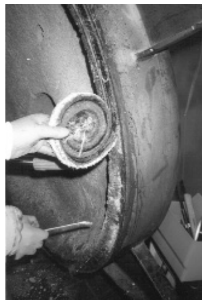
Bild 2: Entfernen der Schnurdichtung an einem Heizkessel
