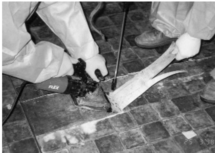
Bild 3: Entfernen eines CV-Bodenbelages
