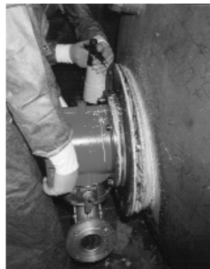
Bild 1: Flachdichtung an einem Heizkessel
