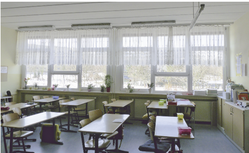
Bild 3: Klassenzimmer der Grundschule in Sachsen im ursprünglichen Zustand (Quelle: IAG/Dresden).
