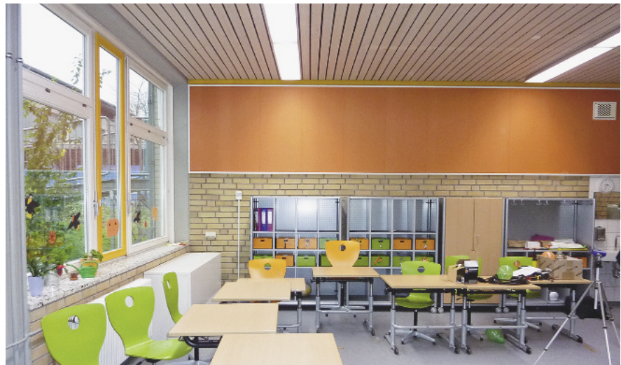
Bild 6: Klassenzimmer der Hauptschule in Nordrhein-Westfalen mit schallabsorbierenden Flächen in Form der Holz-Paneel-Decke und Rückwand.
