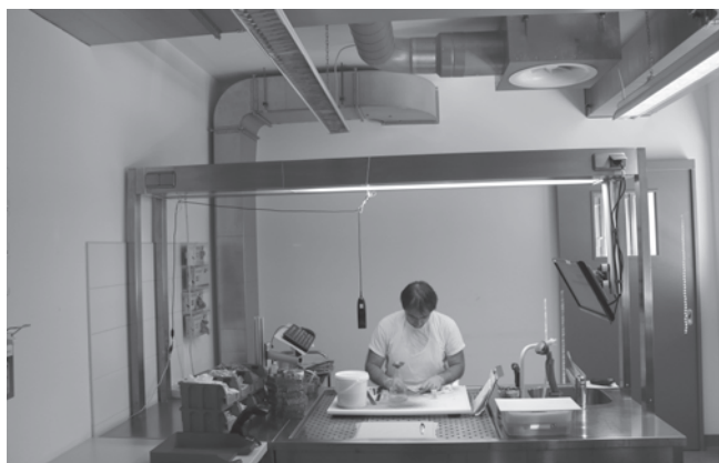
Bild 1. Zuschneideplatz mit Pathologe; Lochblechabsaugung und Zuluft im Deckenbereich. Quelle: Autoren
