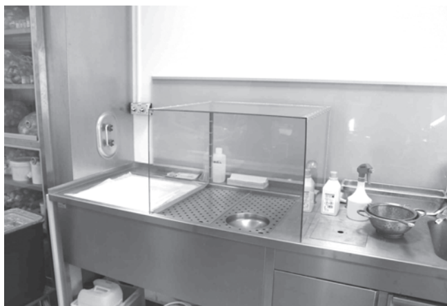
Bild 7. Speziell hergestellte Erfassungshaube (IFA) mit vier Plexiglaswänden über der Lochblechabsaugung. Quelle: Autor
