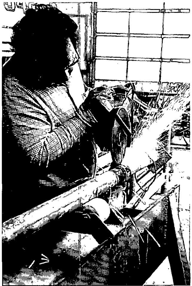
Abbildung 4: Stahlrohrstützen reparieren (B 4)
