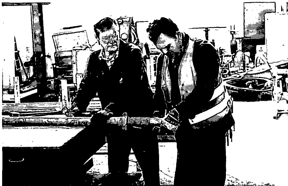
Abbildung 12: Stahlrohrstützen auf einer Stahlplatte richten (B 26)
