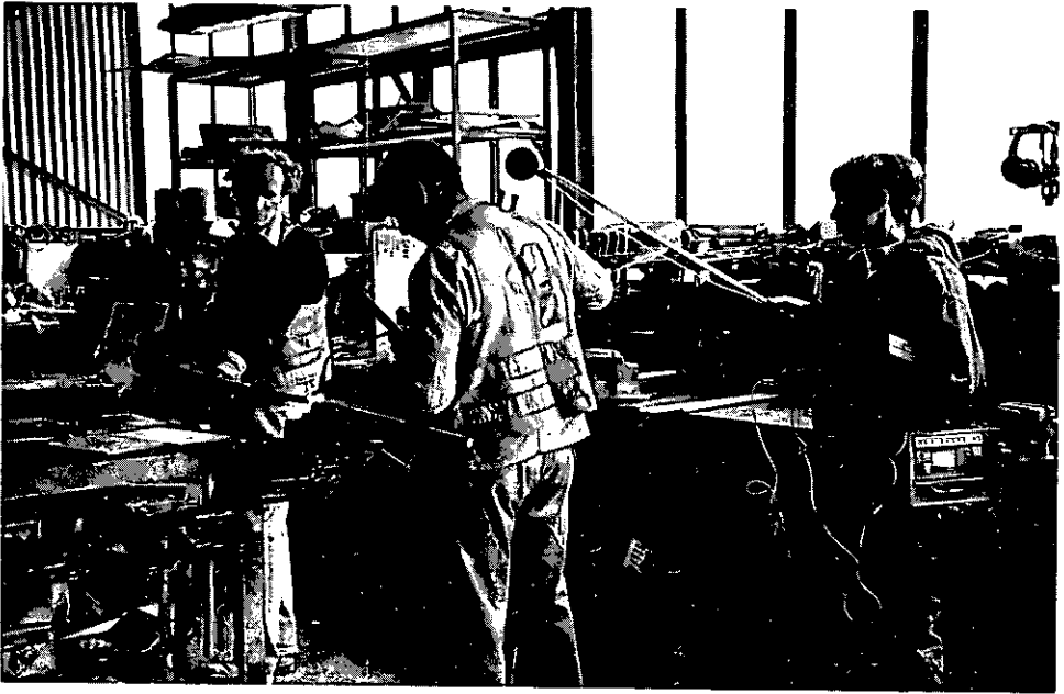
Abbildung 17: Edelstahlanker biegen (B 50, B 51)
