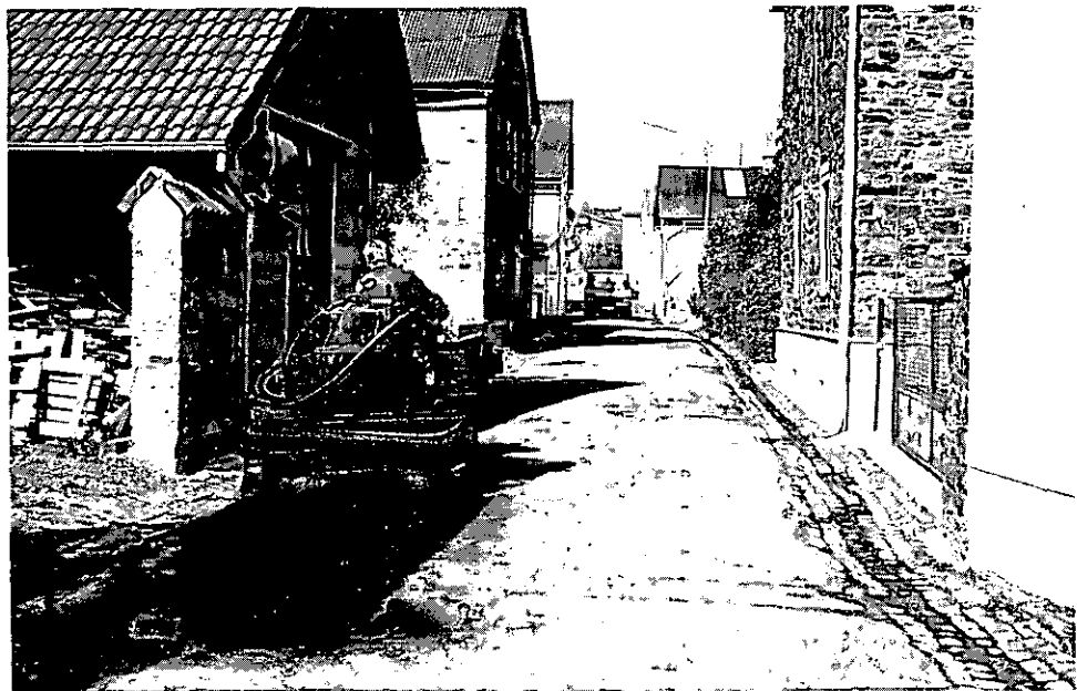
Abbildung 16: Haftgrund aufsprühen (C2 10)
