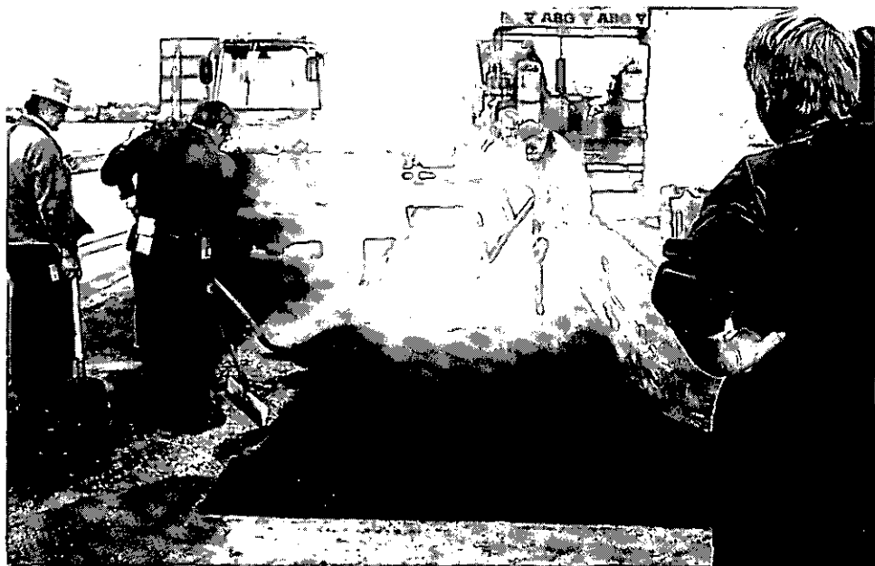
Abbildung 25: Schwarzdeckenhandeinbau (C2 23)
