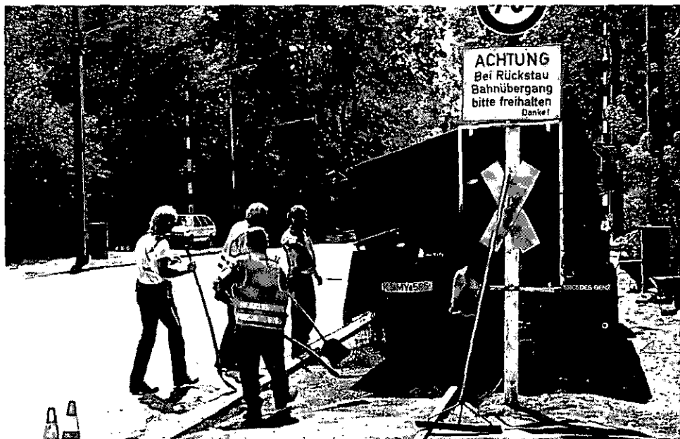
Abbildung 23: Schwarzdeckenhandeinbau (C2 19)
