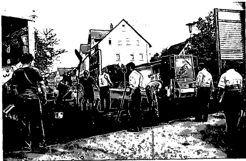
Abbildung 10: Mitgänger am Schwarzdeckenfertiger (C 2 3)
