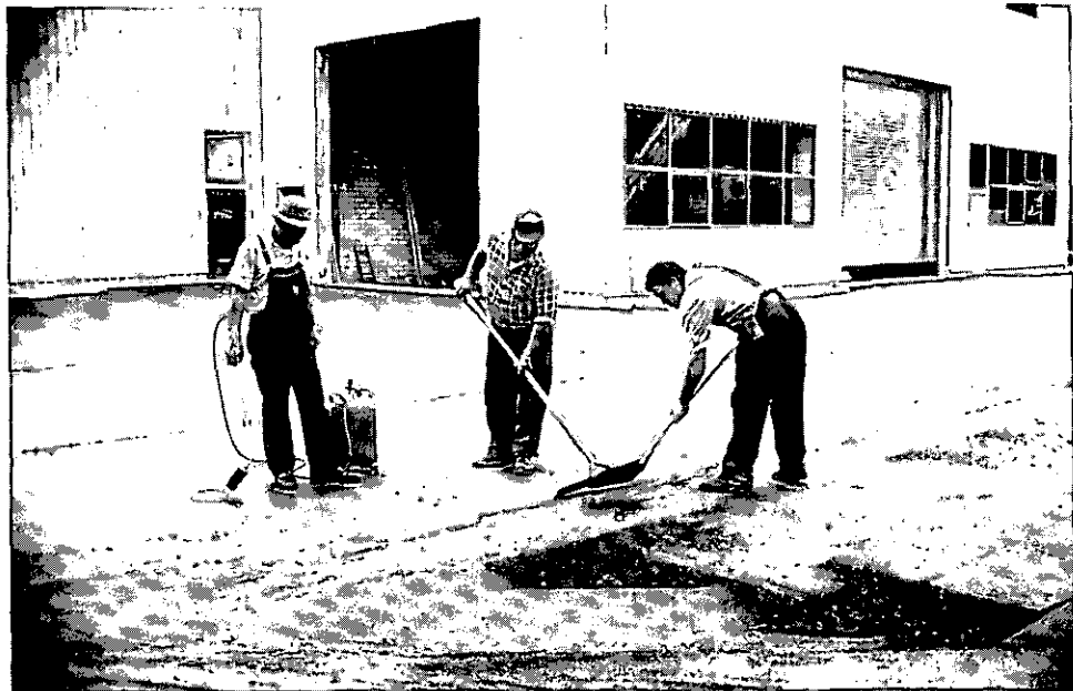
Abbildung 12: Handeinbau von Schwarzdeckenzwickeln (C2 6)
