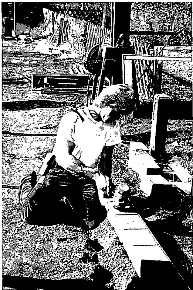
Abbildung 24: Randsteine setzen (C2 21)
