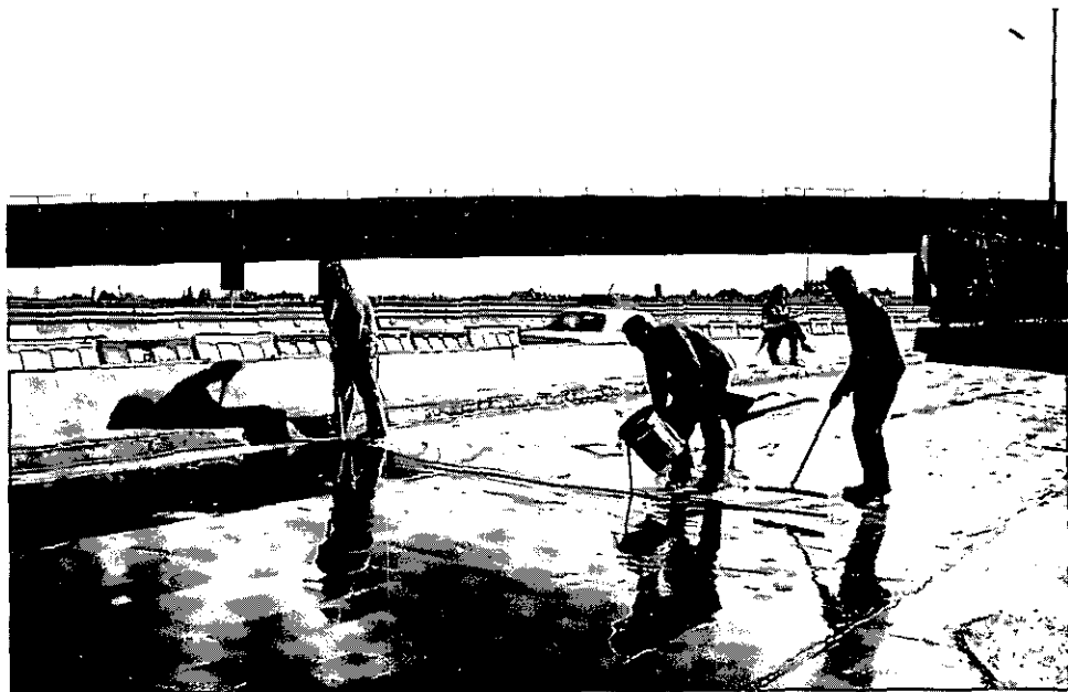
Abbildung 29: Haftbrücke auftragen (C2 31)
