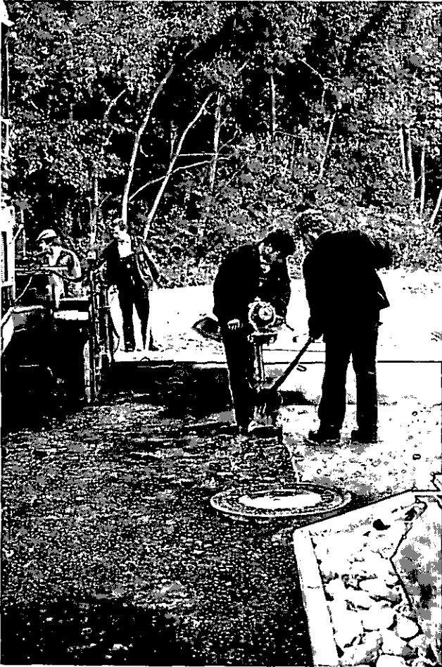
Abbildung 11: Schwarzdeckenkante abstechen (C2 5)
