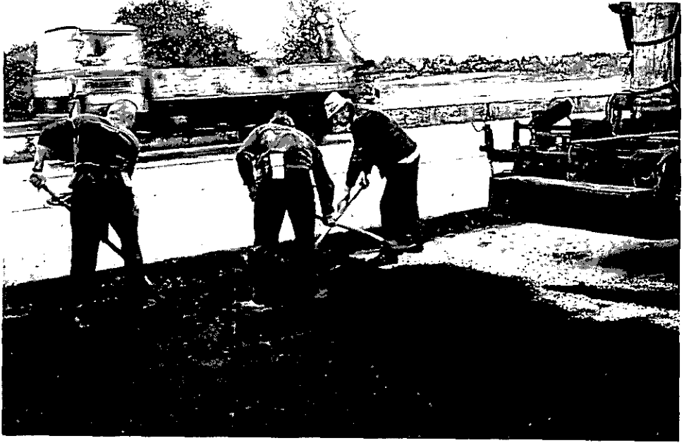
Abbildung 26: Schwarzdeckenhandeinbau (C2 24)
