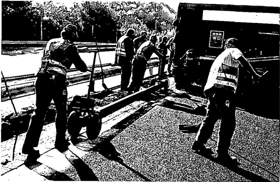
Abbildung 28: Mitgänger am Schwarzdeckenfertiger (C2 30)
