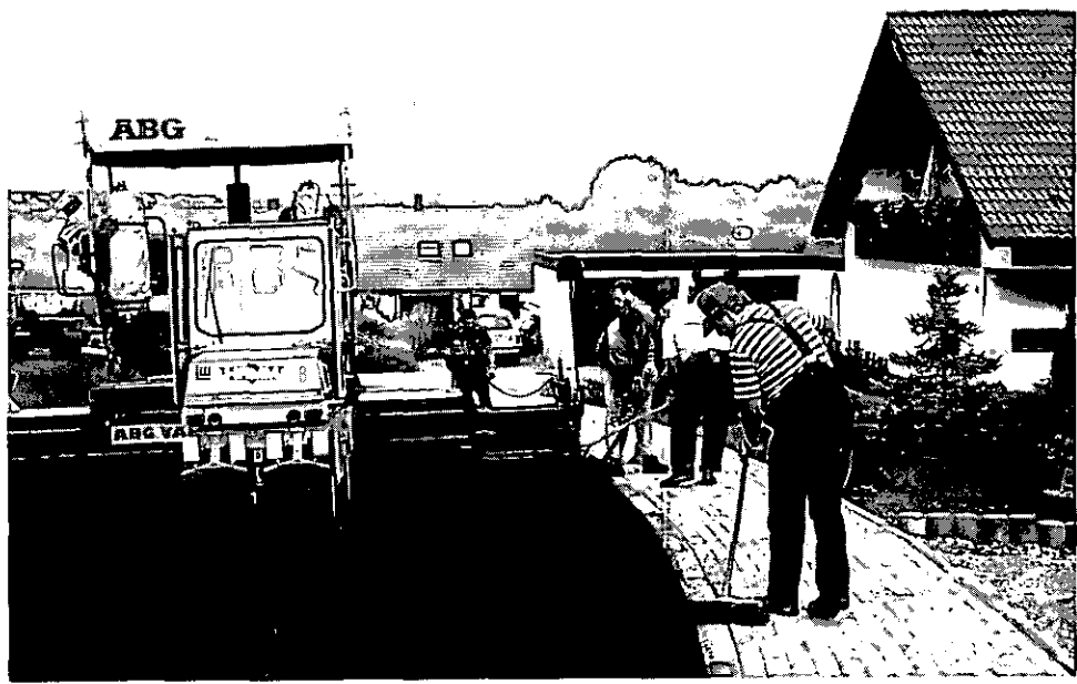
Abbildung 9: Mitgänger am Schwarzdeckenfertiger (C2 2)
