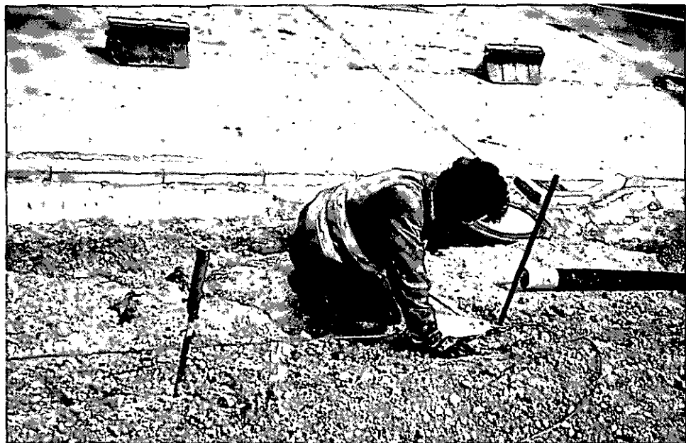
Abbildung 18: Fertigerleitdraht spannen (C3 23)
