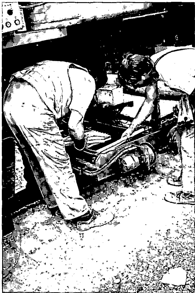
Abbildung 13: Dübel einlegen (C3 18)
