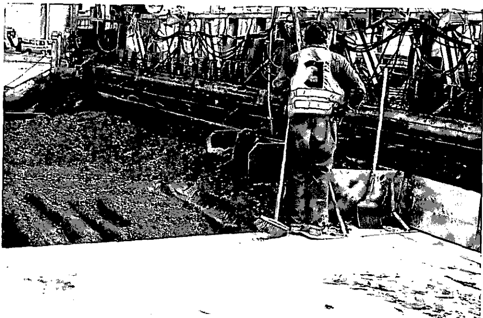
Abbildung 4: Mitgänger am Betondeckenfertiger (C3 3)
