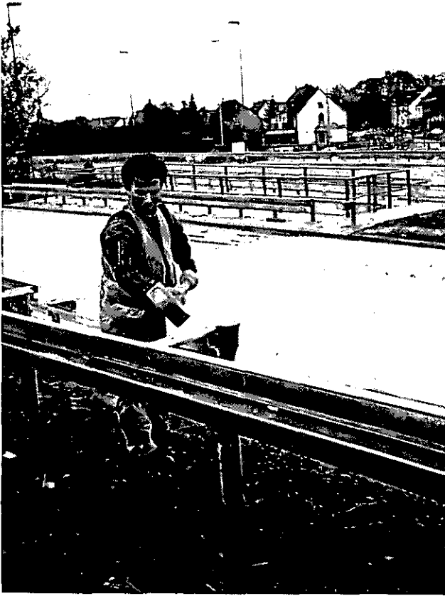
Abbildung 12: Leitplanke richten (C5 13)
