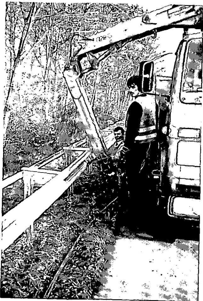
Abbildung 15: Leitplanke richten (Kran) (C5 18)
