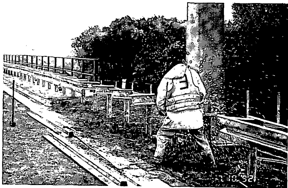
Abbildung 7: Trennen mit Druckluftwinkelschleifer (C5 6)
