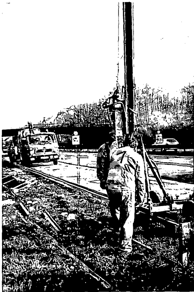
Abbildung 14: Leitplankenpfosten rammen (C5 16)
