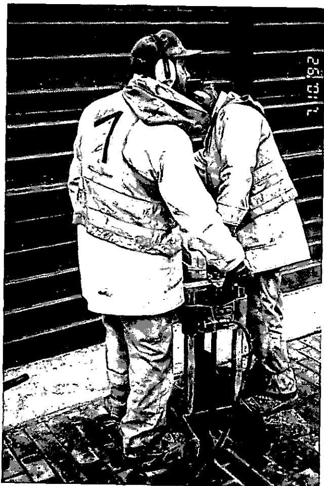
Abbildung 6: Pfostenlöcher in Pflaster bohren (C5 5)
