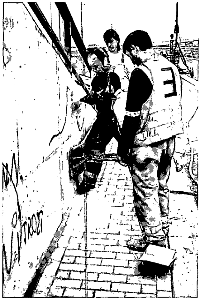
Abbildung 11: Dübellöcher bohren (C5 11)
