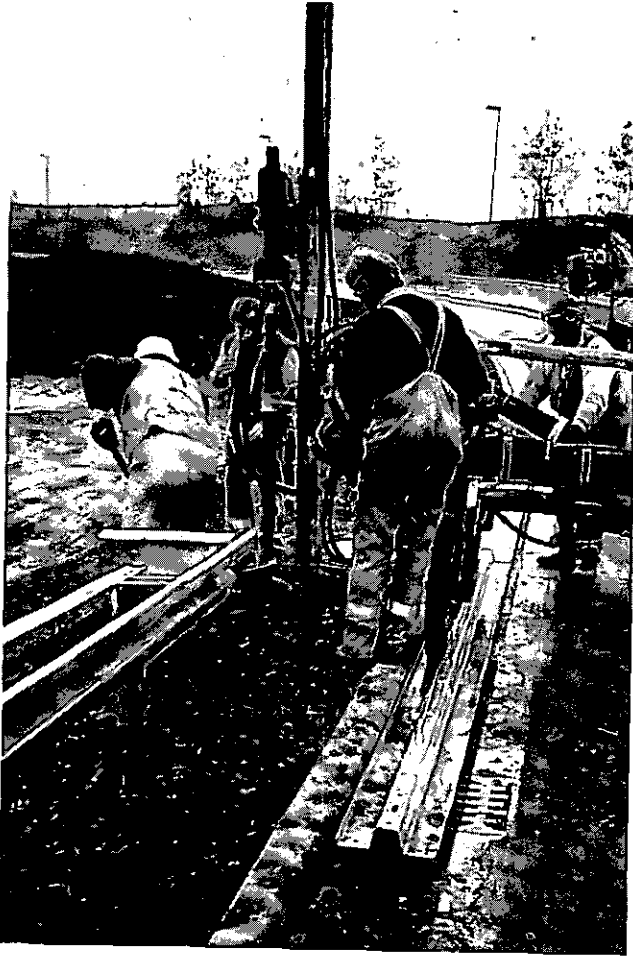
Abbildung 9: Pfostenlöcher mit Schnecke bohren (C5 8)
