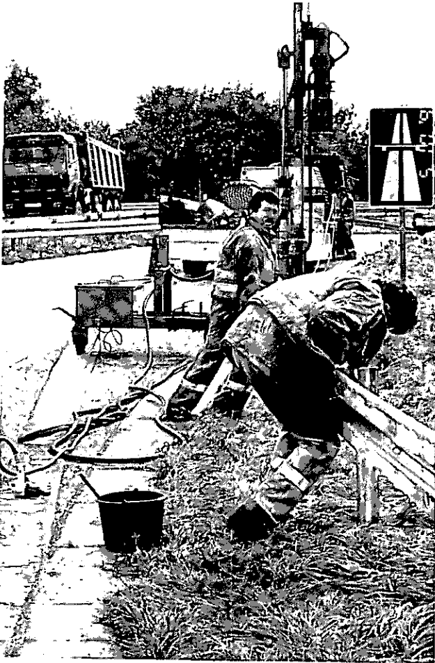
Abbildung 5: Leitplanke richten (C5 2)
