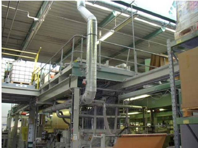
Abbildung 6: Neuinstallation der Rohrleitungen
