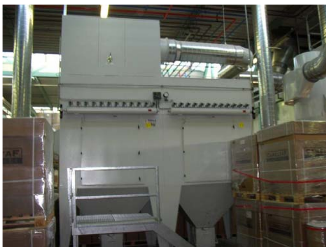
Abbildung 5: Neukonzipierte Abluftanlage
