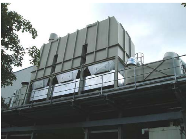
Abbildung 7: Dreikammer-RTO-Anlage
