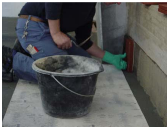
Abbildung 3: Trageerprobung bei Plattierungsarbeiten
